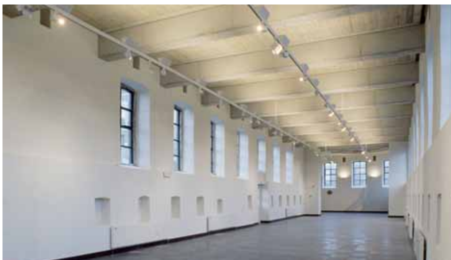
113. Restauration des élévations qui témoignent de la fonction hospitalière : grandes fenêtres hautes placées, armoires murales, ventilation opérée par des trous pratiqués au ras du plafond, entre les poutres du plafond.
