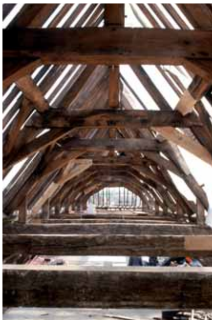
101. Le grand vaisseau de bois, de 1667-1668, où certaines pièces ont été refaites selon la technique traditionnelle de l'assemblage à tenon et mortaise, d'autres réparées en résine. Solides fermes de charpente à entrain et faux-entrain.
