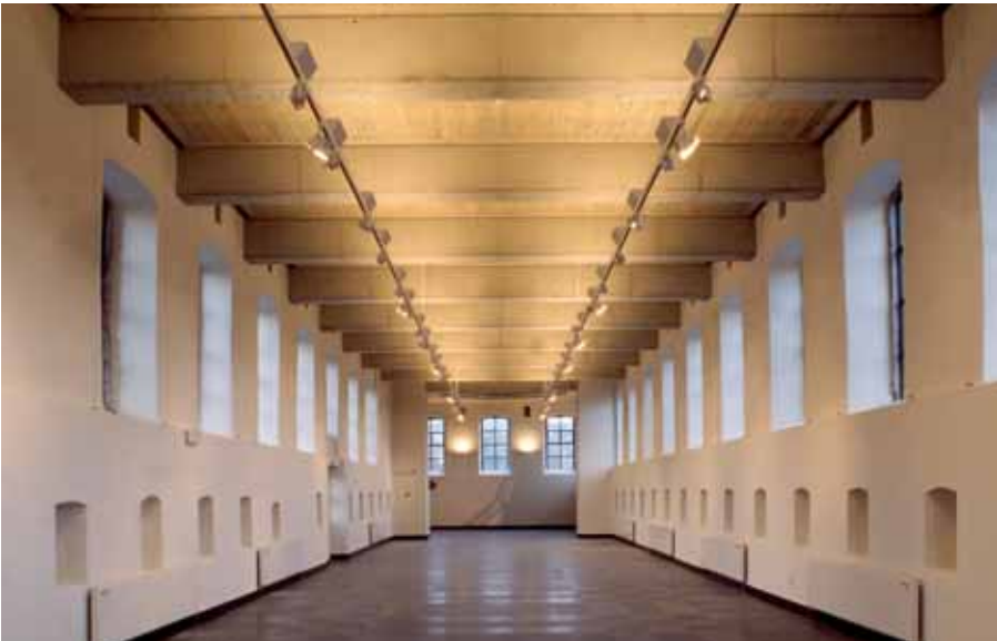
59. La belle et grande salle après sa restauration en 1996 et avant l'installation du Parlement. Elle traduit le mieux l'esprit austère de l'hôpital du XVI e siècle : fenêtres hautes donnant une lumière abondante, armoires murales individuelles, trous d'aération au ras du plafond depuis le début du XVIII e siècle, et communication avec la grande chapelle au fond.
