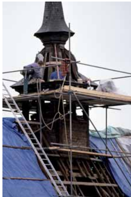
100. Le clocheton de la chapelle en restauration. Le travail a été réalisé in situ , sans dépose en atelier. Certaines pièces de l'enrayure furent consolidées par de la résine.
