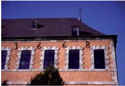
71. Les ancrés de 1668, solidarisant les entrails de charpente avec la façade, affichent du côté du Grognon la date du renouveau de l'hôpital.
