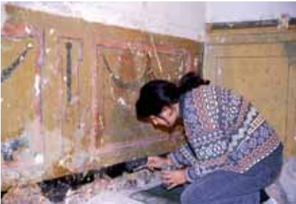
114. Des éléments de décor, lacunaires il est vrai, subsistaient dans l'aile sud-ouest. Une cheminée d'esprit Louis XVI a été remontée en place et les lambris peints du XIX e siècle ont été dégagés et simplement fixés, dans l'attente d'une restauration complète de ce salon.
