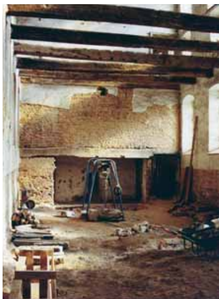
97. La salle des commissions publiques en cours de chantier. Creusement de la voûte pour le passage de la cage d'ascenseur.
