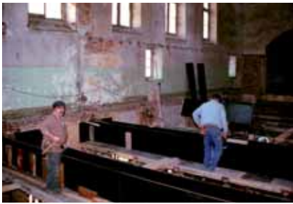
98. Bibliothèque des parlementaires : coffrage des nouvelles structures en béton.
