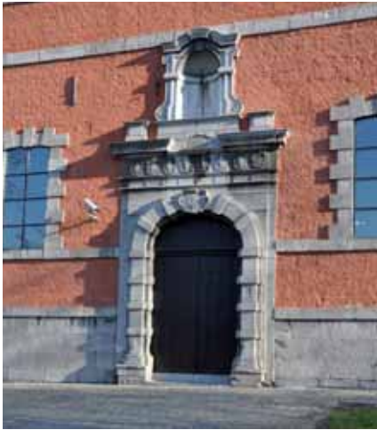
66. Le très beau portail baroque de 1669, entrée officielle de la chapelle, anime la façade austère de la rue Notre-Dame. Une statue de saint Gilles, désormais conservée au Musée des Arts anciens du Namurois, ornait la niche supérieure. Les noms et blasons des échevins, gravés sur l'entablement, ont été martelés (© Th. Cortembos).
