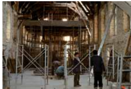
94. Chantier de la grande salle supérieure, aujourd'hui bibliothèque. Échafaudage pour la poutraison nouvelle.
