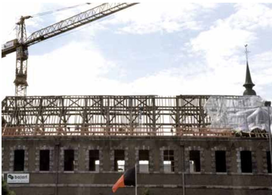
70. L'aile de 1668 et le retour de la chapelle sont couverts d'une imposante charpente en chêne, d'origine, qui développe dix-huit fermes numérotées. Faîtière et sous-faîtière sont raidies par des croix de Saint-André.
