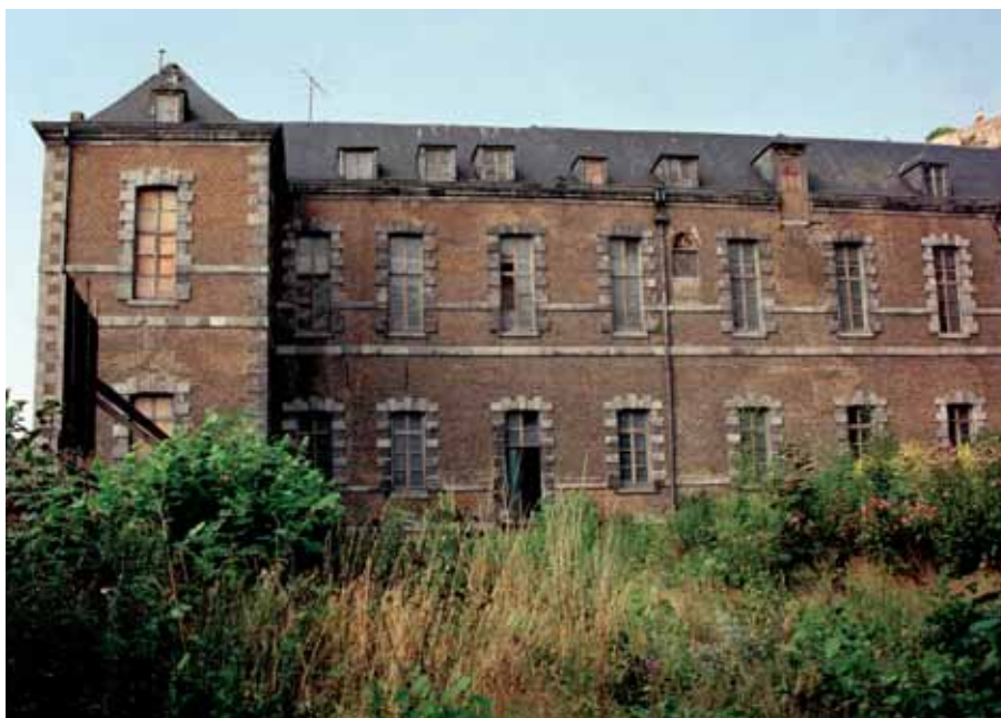
80. Le projet s'est poursuivi par la construction de la dernière aile en 1724, à l'identique. Elle a pris la place d'anciens bâtiments en vue de terminer la reconstitution de l'ensemble. Elle abrite dans les caves toute l'intendance de l'hôpital. État en 1989.
