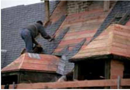
105. L'ardoisier posant les ardoises de Warmifontaine.
