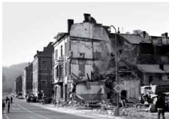
91. La destruction du Grognon le long du boulevard Ad Aquam, fin des années 1960 (photo Jacques Bouton © APN).
