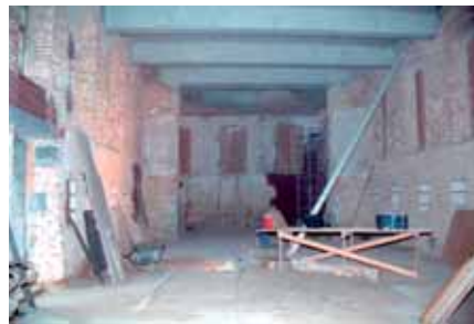
95. La grande salle en cours de restauration. Les structures de béton sont réalisées, selon le rythme de la poutraison ancienne. L'octogone au-dessus de la chapelle est terminé. On aperçoit les anciennes armoires murales, avec les traces bien visibles des deux planches.
