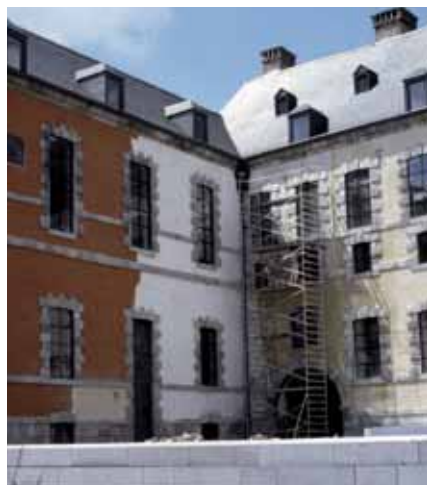
109. Les premiers essais d'enduit et badigeon, menés en 1988.
