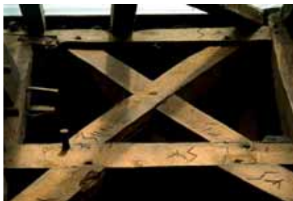
102. Numérotation des structures à l'extrémité sud-est de l'aile nord-est, spécifique aux zones d'angle. Sont visibles les marques préparatoires aux marques définitives.
