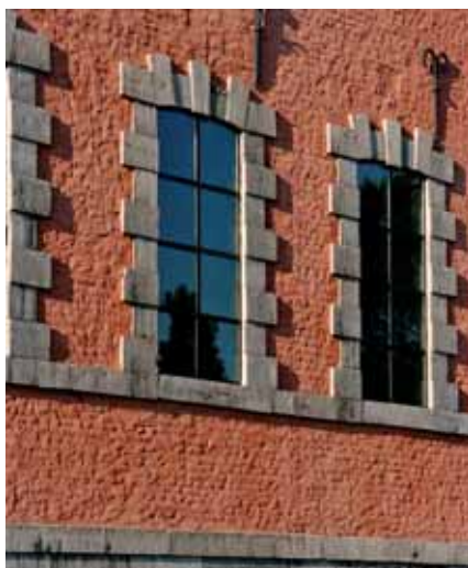
108. Finesse des nouveaux châssis posés telle une membrane à fleur de mur (© Th. Cortembos).
