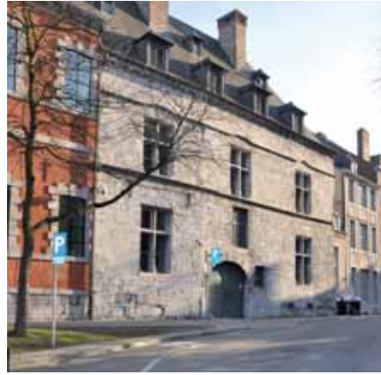
38. La façade de pierre de tradition gothique, soigneusement appareillée en calcaire. Des cordons-larmiers en soulignent finement les deux registres (© Th. Cortembos).
