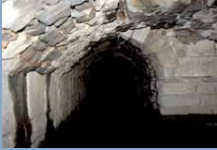
49. Le courot , égout principal du site, traverse toujours la cour du Parlement. Construit en 1531, il présente des murs droits en gros blocs de calcaire appareillés portant une voûte en moellons. Son tracé de quelque deux cents mètres est bien attesté par les textes.
