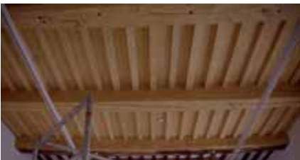
115. Intéressant plafond du début du XVIII e siècle, restauré.
