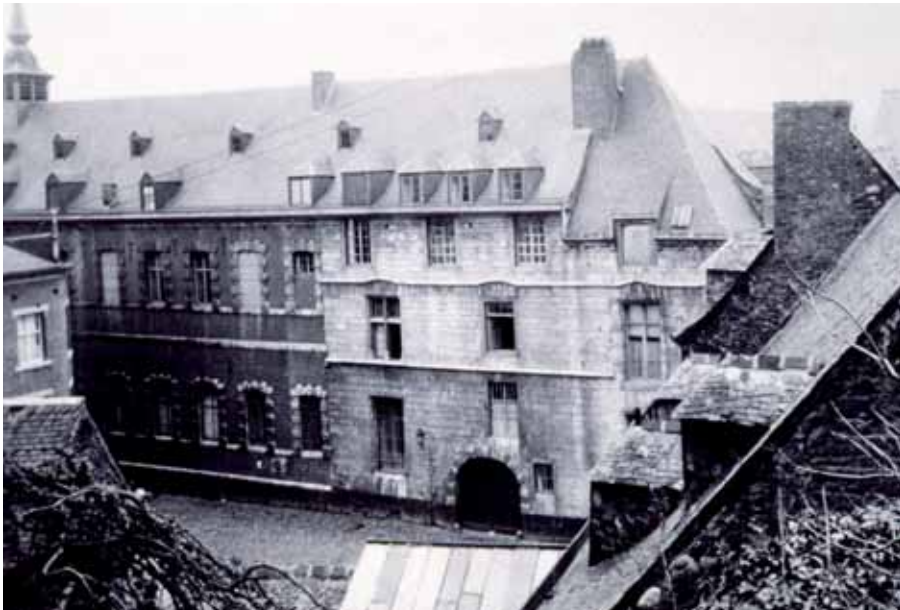
39. Le bâtiment du XVI e siècle subit d'importantes transformations en 1701 : percement du porche, surélévation partielle, nouvelles fenêtres © Archives de la Commission royale des Monuments, Sites et Fouilles de la Région wallonne, dossier Namur 2.3. Début du XX e siècle.
