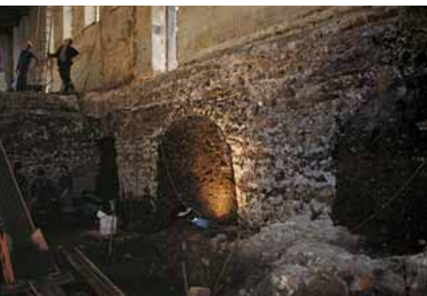
55. La nouvelle aile de l'hôpital est fondée en 1667 sur d'importantes piles en moellons qui portent de grands arcs de décharge. Elles sont coffrées à même la terre, dans la chaux vive. Cette technique perdue encore au début du XX e siècle, aux moulins de Beez.
