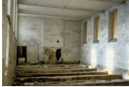
72. Ancien dortoir ménagé au-dessus du réfectoire, avant restauration. Son équipement était similaire à celui du rez-de-chaussée, outre un petit lavabo de pierre encastré dans le mur (disparu).
