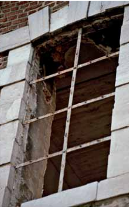
61. Un châssis primitif encore en place. L'armature métallique est fixée dans le tableau de la fenêtre, et non en battée. Sa division principale, en huit carrés, est modulée sur l'encadrement de pierre. Une subdivision plus fine, en 9 petits carreaux, permettait l'accrochage de petits vitrages par du plomb.
