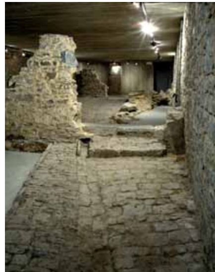
35. Aujourd'hui couvertes sous la cour du Parlement, les zones de circulation à l'air libre correspondent à l'arrière de la maison Colle.
