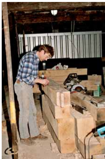
103. Le charpentier Marcel Oswald confectionnant les nouvelles pièces sur le chantier.
