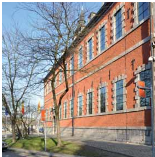
57. Le travail de la pierre calcaire, finement taillée au ciseau, donne au bâtiment toute sa noblesse. Soubassement, anglées, bandeaux et fenêtres structurent fortement l'élévation, en dialogue avec la brique rouge (© Th. Cortembos).
