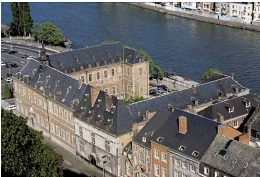
37. L'ensemble, apparemment homogène, englobe à droite un bâtiment de pierre calcaire, de tradition gothique, seul vestige de la campagne de construction du début du XVI e siècle.
