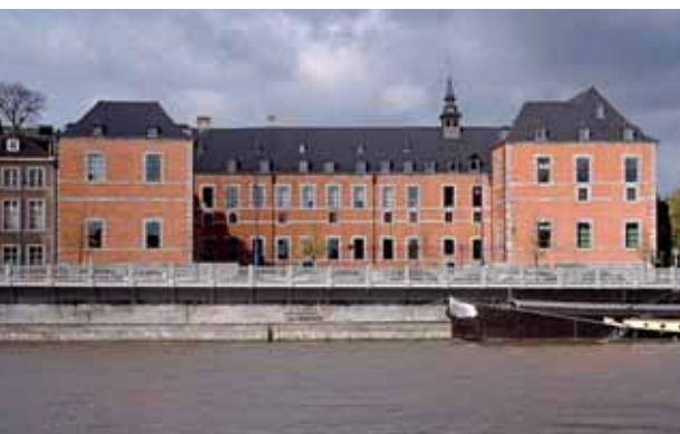
52. L'ensemble du monument vu depuis la rive de Jambes, avant la construction de la galerie vitrée. Architecture d'inspiration Louis XIII, mais avant tout fonctionnelle, où l'unité prédomine malgré les nombreuses contraintes antérieures imposées par le site (photo J.-L. Javaux, 1998 © SPW-DPat).
