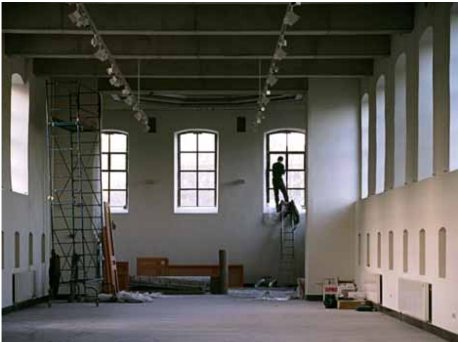
107. Pose des châssis. Structures visibles depuis l'intérieur.
