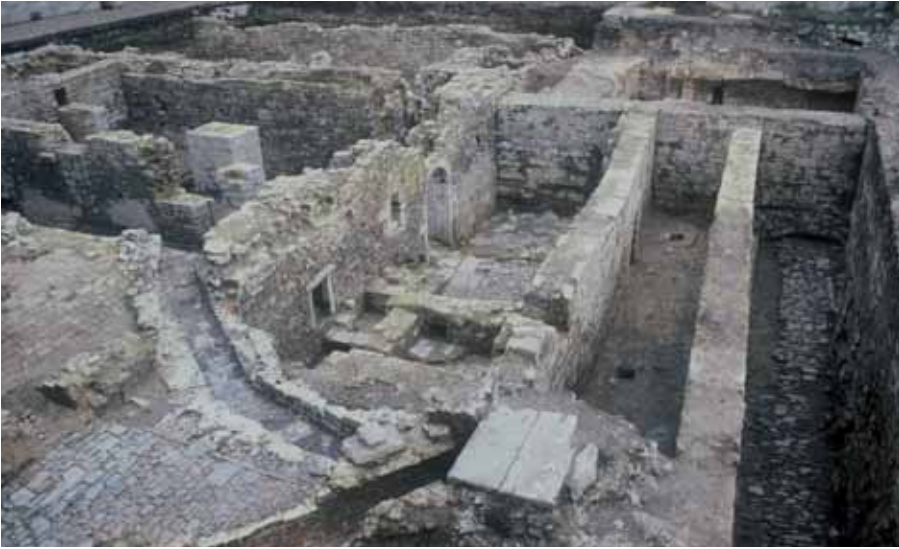
45. Le nouveau dortoir (en haut, à droite) est implanté sur le courrot voûté; les caves en briques ont été dégagées lors des fouilles de 1990.
