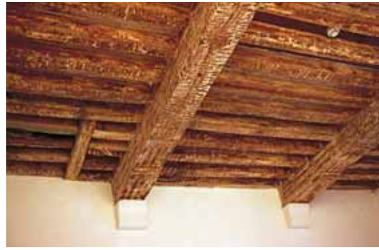
41. Plafond d'origine au rez-de-chaussée du bâtiment du XVI e siècle. Sa structure était primitivement apparente et peinte en rouge-brun. Ses poutres maîtresses conservent les semelles décorées de motifs géométriques, courants à cette époque.
